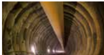
复杂地质条件下超大型地下工程建设技术（雅砻江锦屏二级引水隧洞群）
