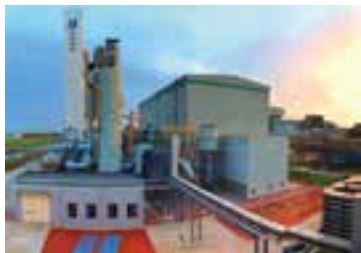
天津 IGCC 电厂
