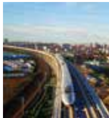
鞍钢牌时速 350 钢轨应用 于京沪铁路
