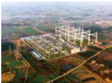
特高压试验示范工程 - 荆门站
