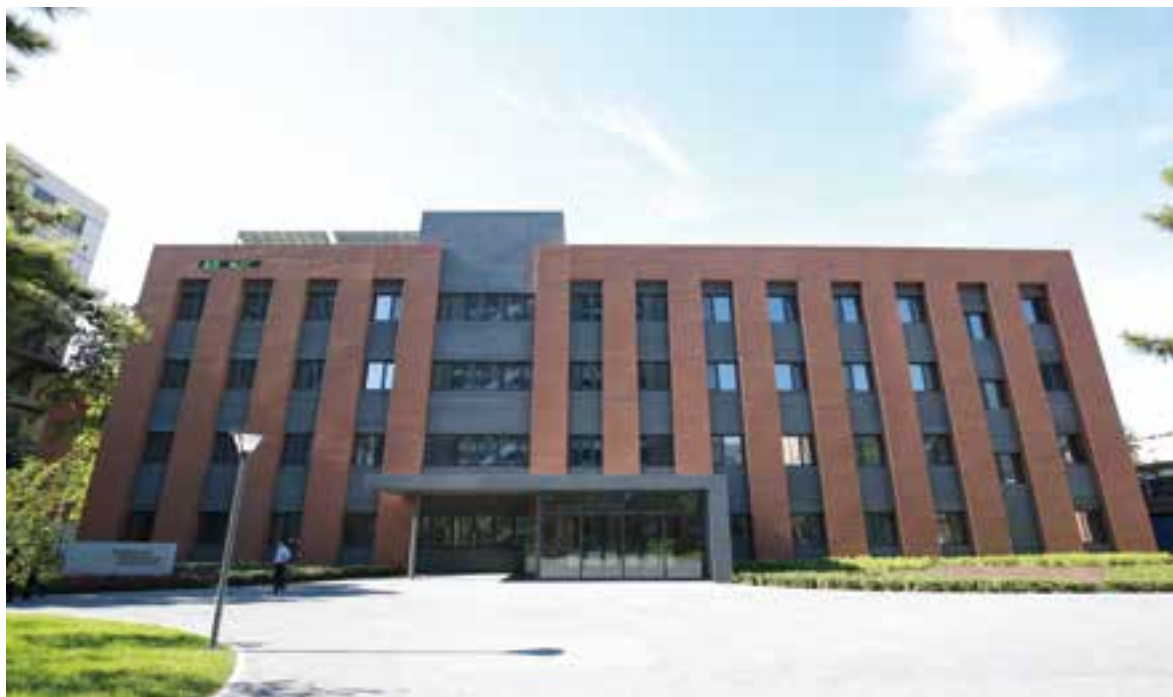
中国建筑科学研究院近零能耗示范楼
