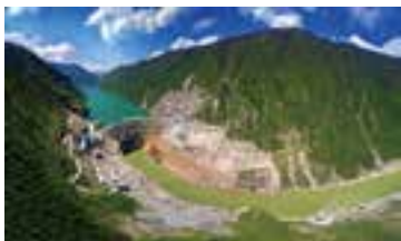
建成了世界第一高拱坝锦屏一级水电站大坝，坝高 305 米
