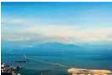
港珠澳跨海通道大桥
