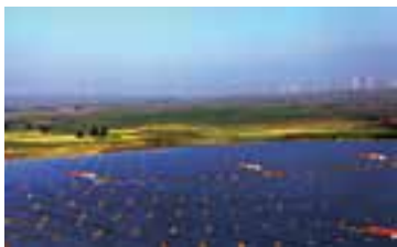
国家风光储输示范工程
