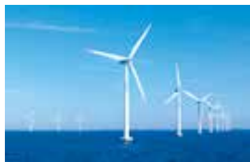
大型海上风电场建设技术（江苏如东近海风力发电工程）
