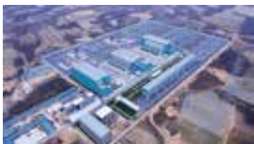
建成了哈密南 - 郑州 ±800kV 特高压直流输电工程换流站
