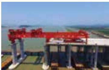
JQ1300 型架桥机和 YL1300 型运梁车
