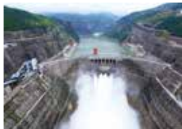
300m级超高拱坝建设及数字化建造技术（溪洛渡水电工程）
