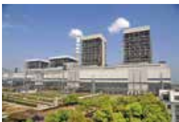
建成了世界综合指标最优的首座百万千瓦二次再热高效清洁燃煤发电工程 - 泰州电厂二期工程
