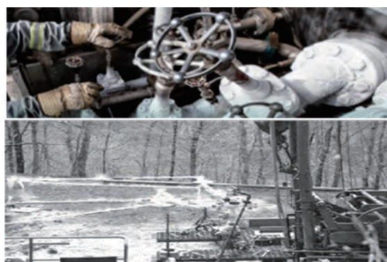
图 16 液氮压裂用的井口 [6]
