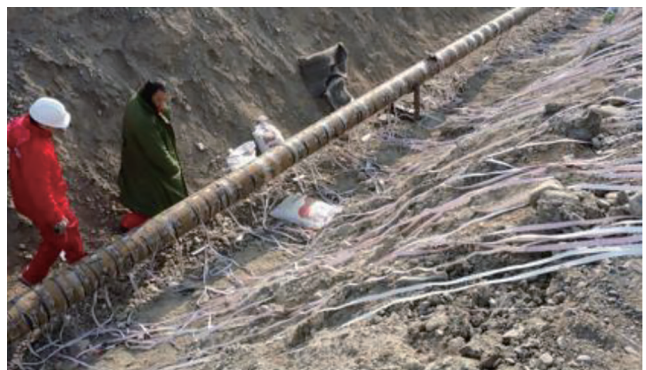
图 11 打压管道应力原位检测现场
