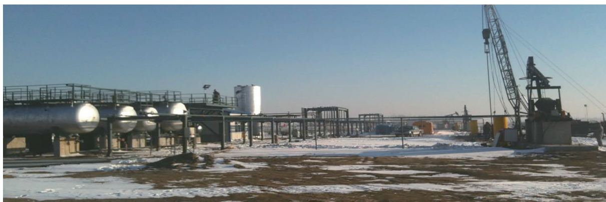
图 13 众诚油页岩原位转化试验现场 [30]
