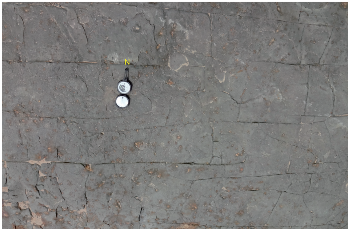
图6 延长组呈雁列式排列的高角度构造裂缝
