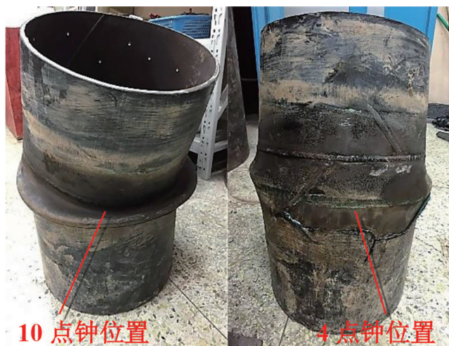
图 1 管道皱褶形貌
