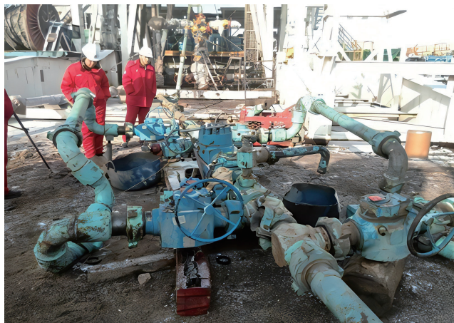
图 8 通过旁通管线添加暂堵剂
