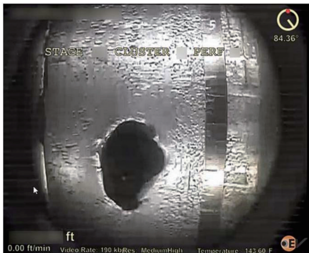
图 13 压裂后炮眼成像显示被严重冲蚀 [133]
