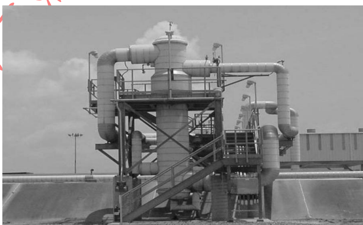
图 10 再冷凝器外形图
