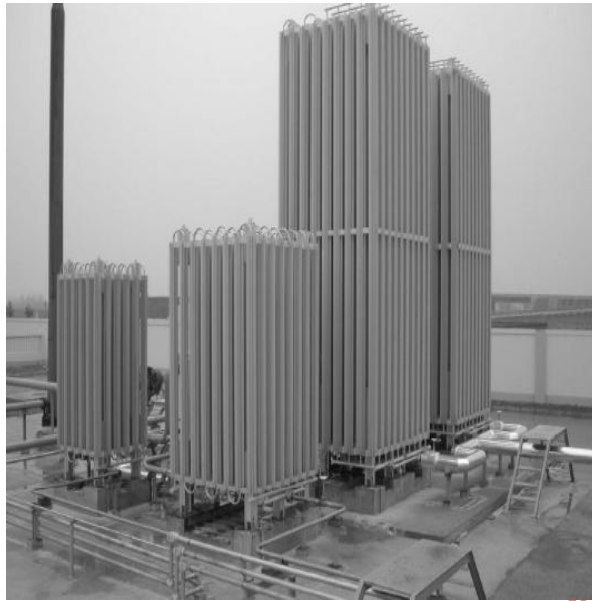
图 7 空气加热型气化器结构图
